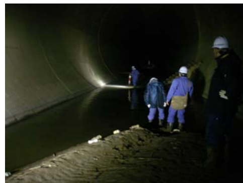
トンネル内の調査の様子
