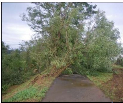
堤防に倒れた樹木
