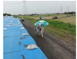
小貝川堤防での牽引式電気探査風景
