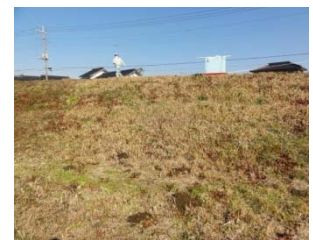
霞ヶ浦堤防でのスリングラム電磁探査風景
