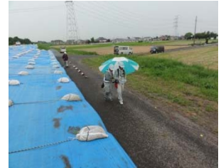
小貝川堤防での牽引式電気探査風景
