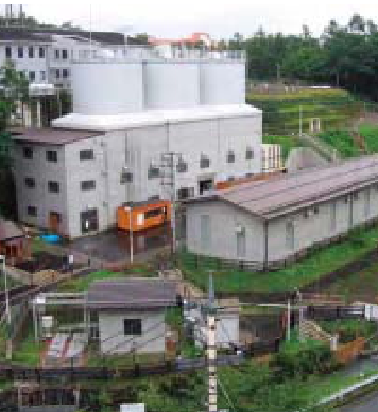
湯川へ石灰水を投入する草津中和工場
