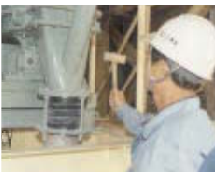
石灰の投入口
