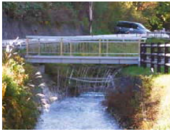
湯川への石灰水の投入状況
