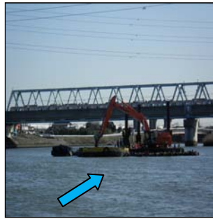
溜まった土砂を掘っています。
