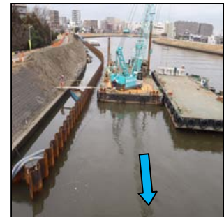
鋼矢板の打ち込み完了です。
