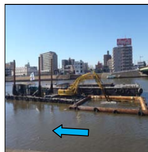
水道管の上に溜まった土砂を掘っています。
