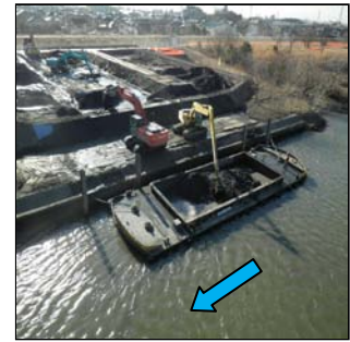
掘った土砂を仮置きしています。
