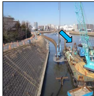
鋼矢板を打ち込んでいます。
