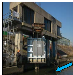
補修するため、扉体(ゲート)を一時取り外しています。
