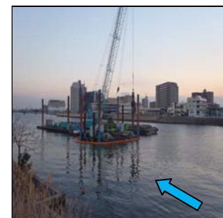
水道管を撤去しています。
