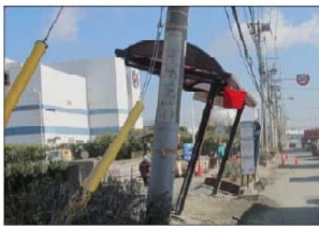
写真 1-24 路上でのバス停留所施設の損壊（千葉県浦安市）
