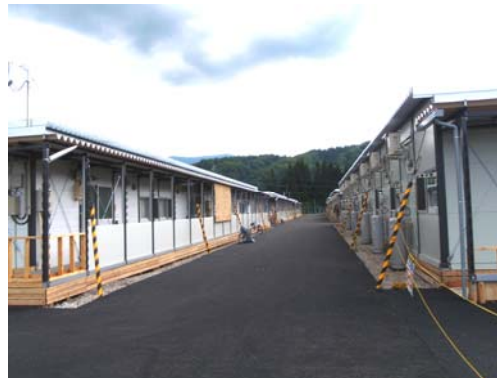
写真2-5 外観写真(栄村農村広場)
