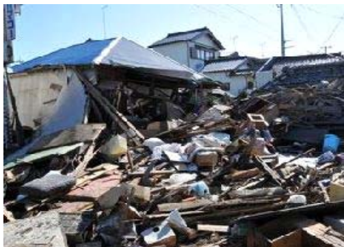
写真 1-2 津波による倒壊家屋と押し寄せたがれき
