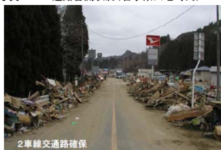
写真2-7 道路啓開状況(岩手県田老町内)
