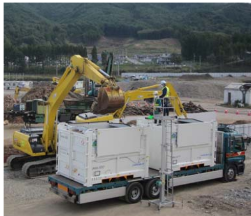
写真 2-6 岩手県山田町仮置場でのコンテナ積込作業
