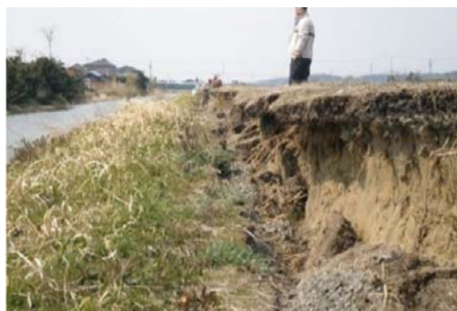
写真 1-29 茨城県稲敷市 水路法面の崩壊
