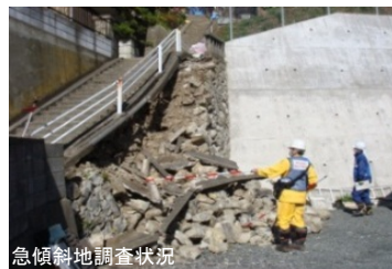
急傾斜地調査状況
