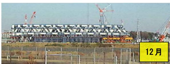
鶴見川の小机大橋と亀甲橋の間（都筑区川向町）で三角形を組み合わせたようなものができていますが、これは鶴見川に流入している大熊川を横断する橋梁の一部です。
