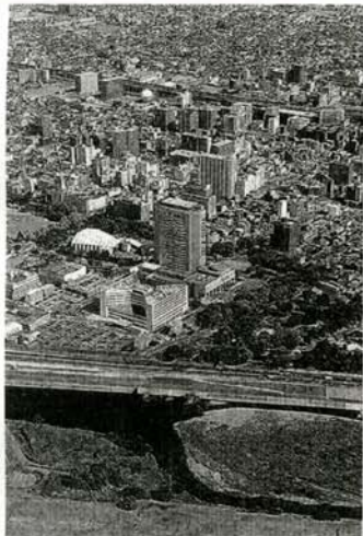
国が作成した「氾濫図」では、手前の鳥川から氾濫し、高崎駅（奥）付近も浸水したことになる＝群馬県高崎市の、本社へ「おおづる」から
