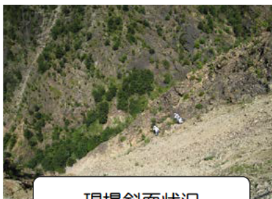
現場斜面状況
