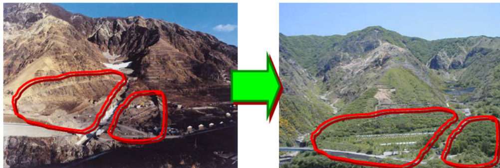
①施工前の写真 (山腹に擁壁を入れ植樹します) ②木々が成長した現在の写真です。
