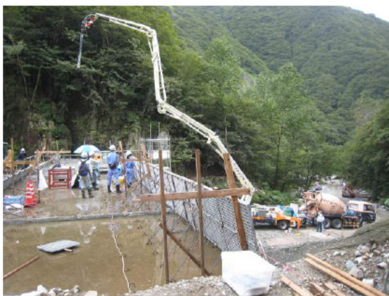
③ コンクリートを入れて嵩上げていきます。
