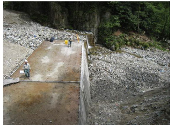
② 工事着工後の写真です。
