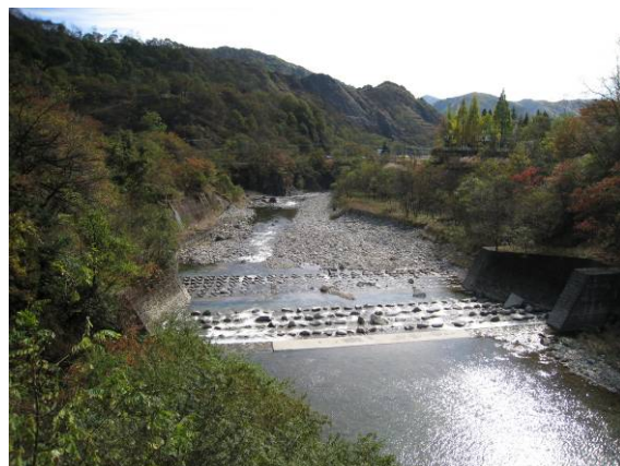
足尾砂防堰堤下流床固群（間藤地先）
