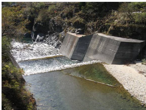
足尾砂防堰堤下流床固群（赤倉地先）
