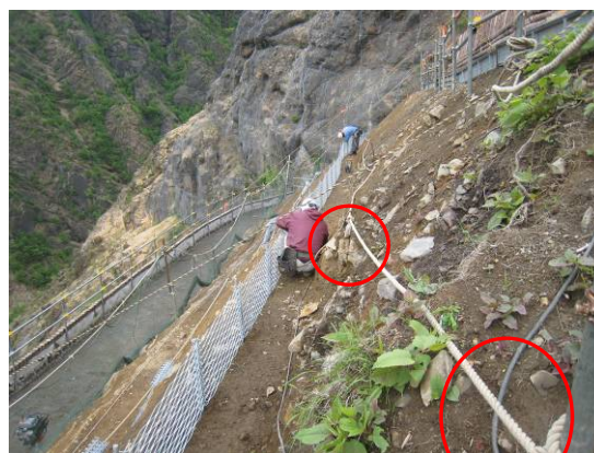
②現場の安全を各々確認 (命綱はしっかりと張られているか)
