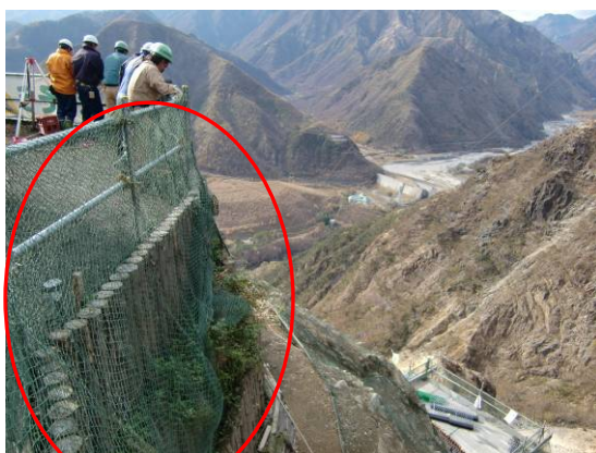
③ 現場の安全を各々確認 (フェンスからの落石防止対策)
