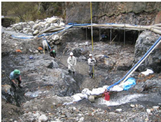
③土砂と岩盤を掘削します。
