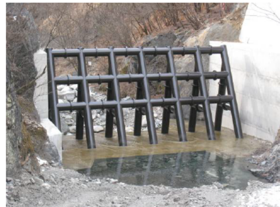
④コンクリートで基礎と両岸を固め鋼管を据え付けて完成です。
