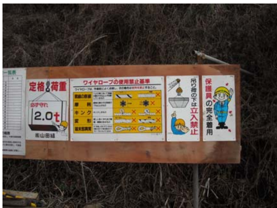
現場での注意喚起の看板
