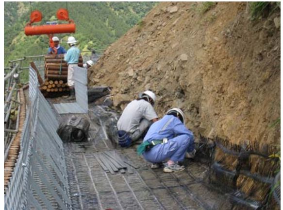
工事現場での作業
