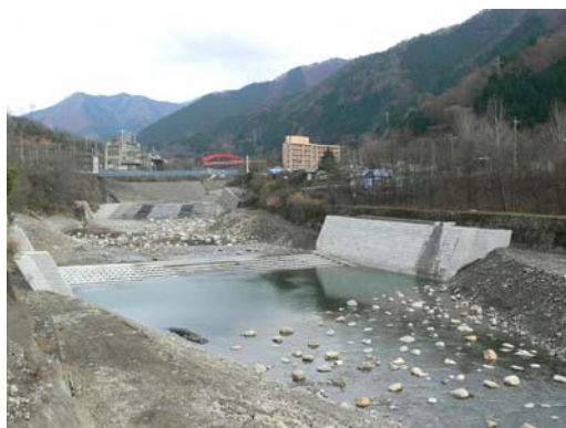
砂畑地先の床固工
