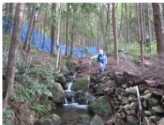
危険箇所点検の様子②
