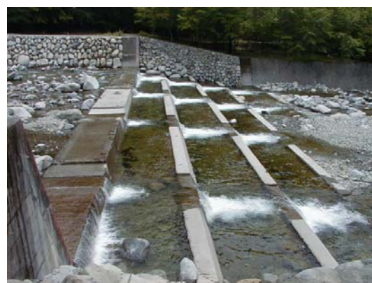
神子内地先の床固工
