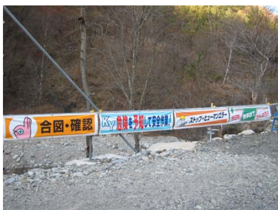
現場には注意喚起の看板が設置してあります。
