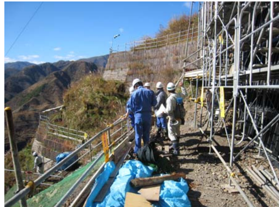
点検の様子（手すり等の安全確認）
