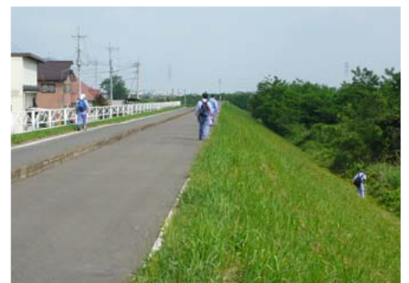
堤防の天端や法尻に別れて歩く堤防点検
