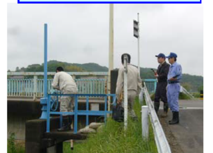
樋管の履行検査の様子
