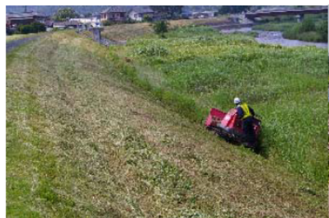
堤防除草工事の状況
