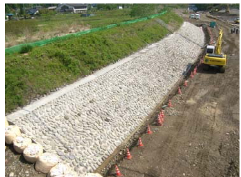
一部完成した流路護岸工
