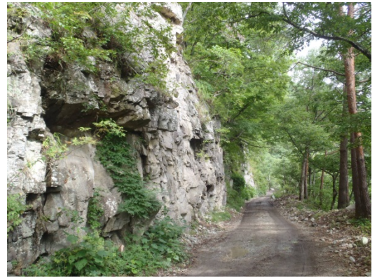
写真-3 工事用道路工事の状況
