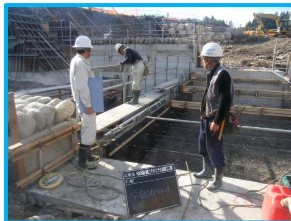
(作業手順確認)
