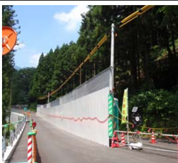
写真-2 仮囲い設置
