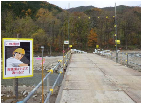
仮橋のソーラーライト設置状況
