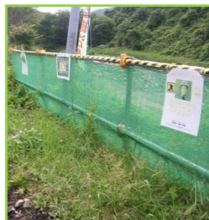
写真-5 立入禁止柵
