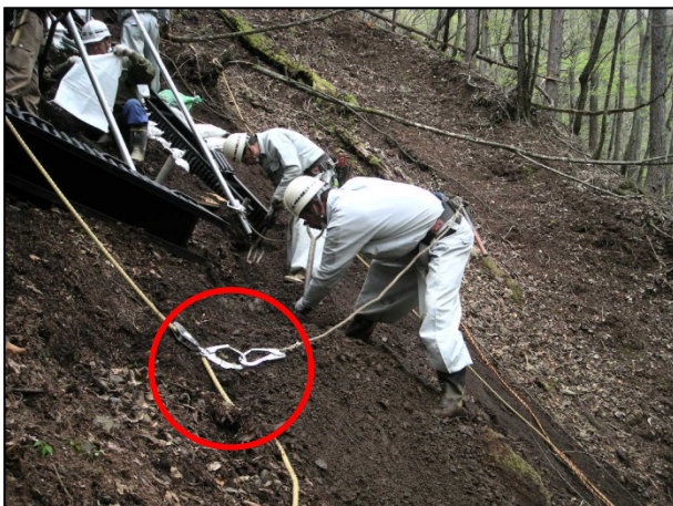
急斜面での縦断方向安全帯使用例
