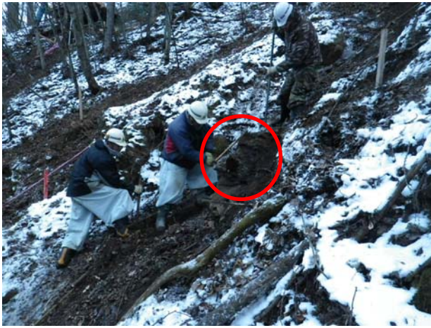
始業前の浮石点検状況
