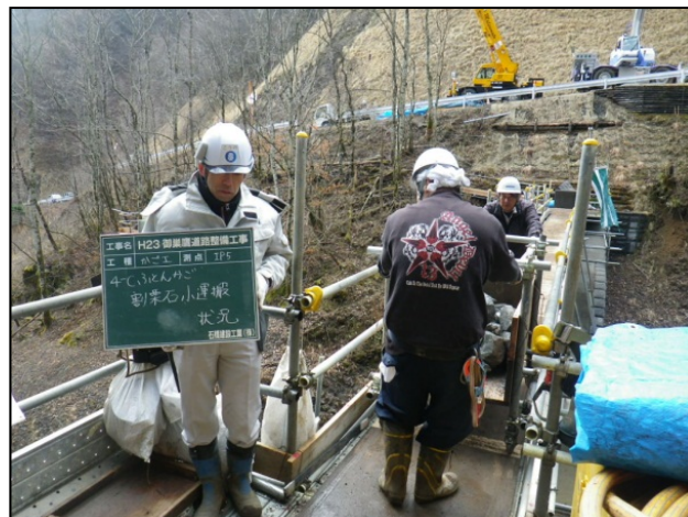
堰堤上足場での運搬状況
