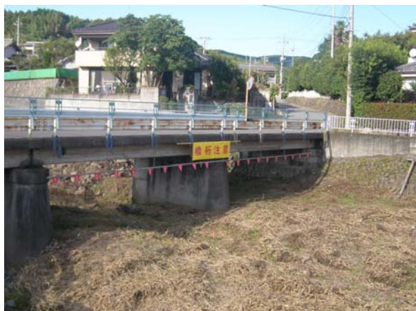
橋桁・橋脚への接触防止対策（全景）
