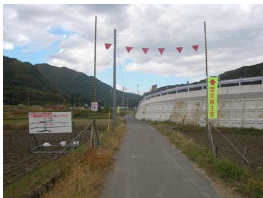
〔門型ゲート設置状況〕
