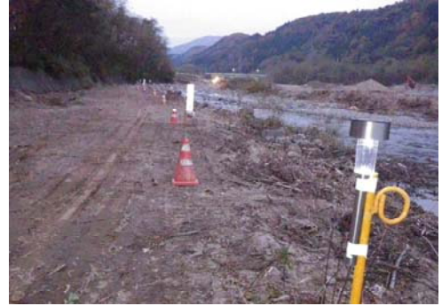
夕暮れ時の点灯状況
