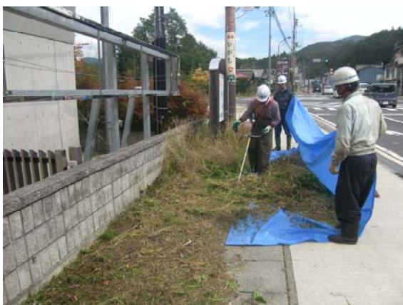
[防護措置状況]
