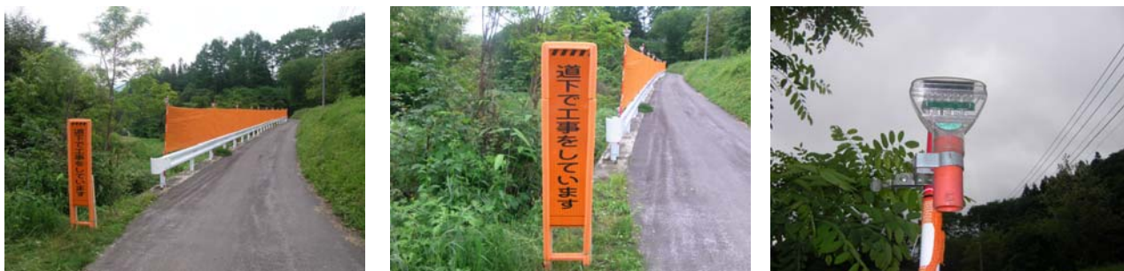
町道に設置した看板とオレンジネット・点滅灯
