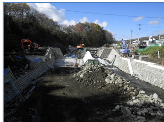
写真-1 11月現在 現場全景
