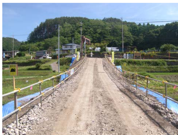
仮道路（国道を望む）
