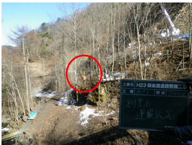
索道による運搬状況
