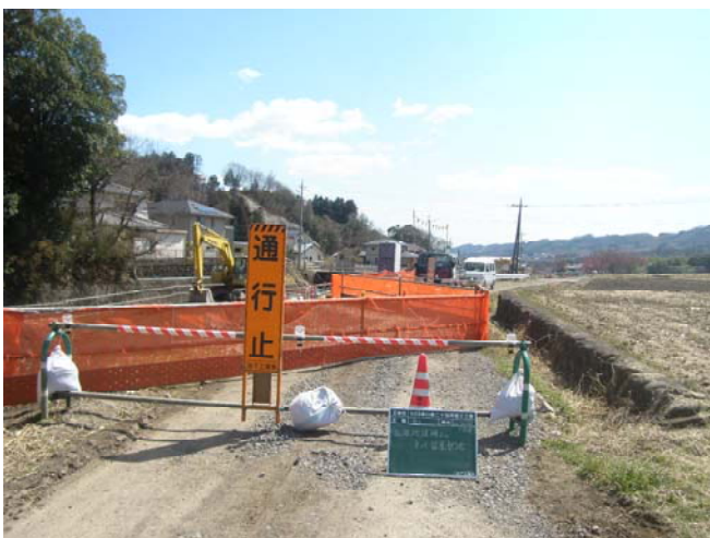
切土部での立入り・転落防止対策
