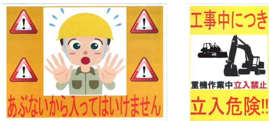
仮道路の外周に設置した掲示物
