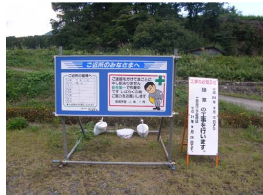
〔工事予告看板設置〕
