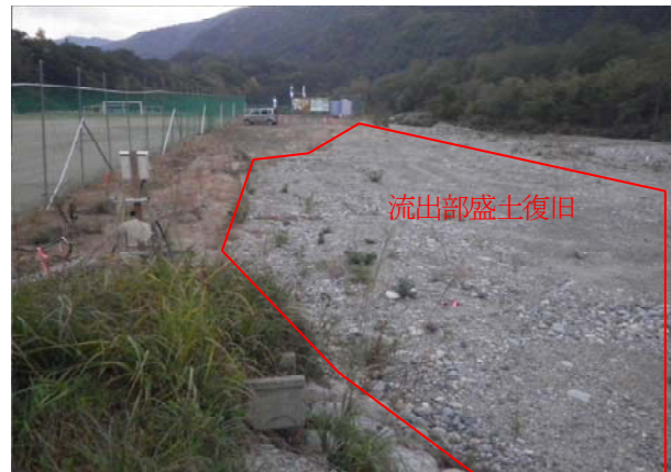
流出部盛土復旧 (下流護岸施工箇所)
