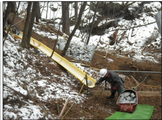
各施工箇所へのシュートによる運搬
