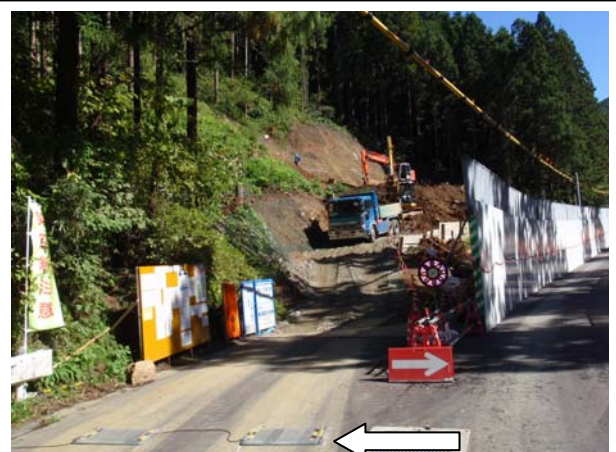
写真-6 トラックスケールの使用
