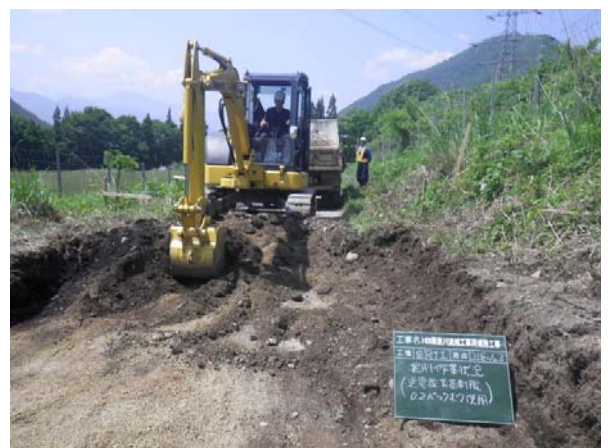
送電線下は小型機械で施工する
