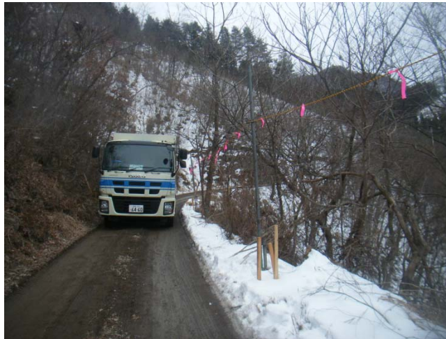
大型車両目線高防護柵設置
