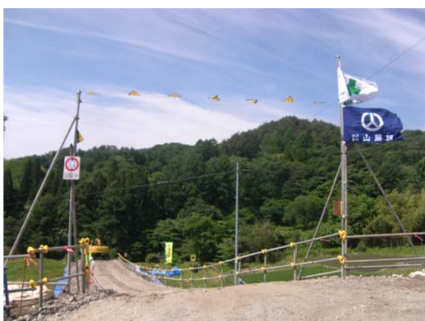
仮道路（国道より望む）
