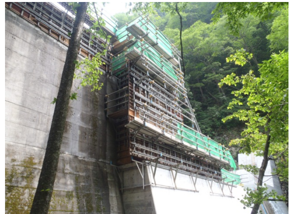
写真－1 堰堤改良工事の状況
