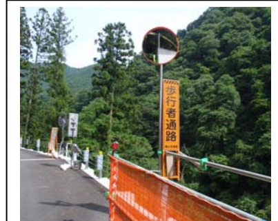
写真-4 カーブミラーの設置
