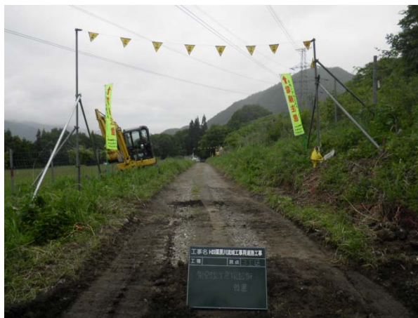
送電線下に三角旗を設置(H=4.0m)
