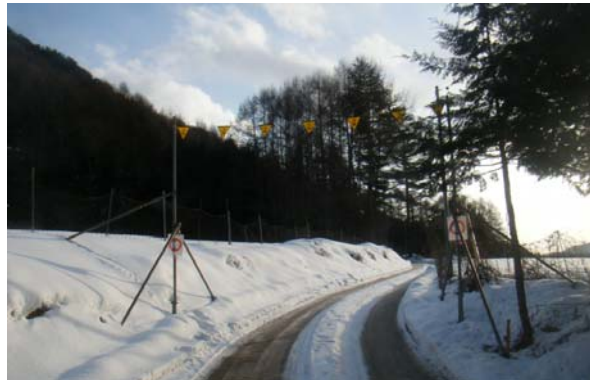
現場出入口に三角旗を設置(H=3.8m)
