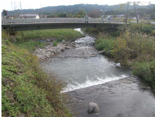
江戸村橋と既設24床固工
