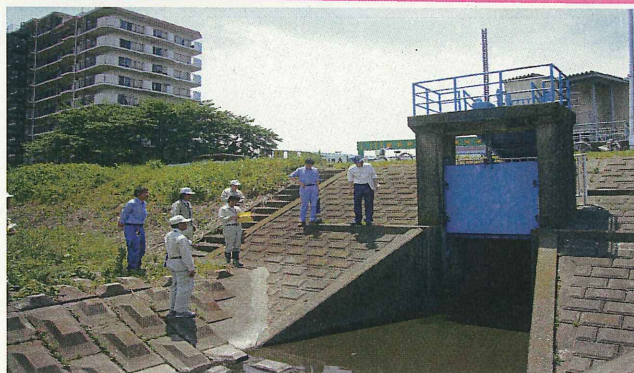
樋門・水門（用水の取り入れや排水の通水路）の履行検査 5月実施
