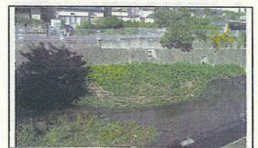
平瀬川は初山一丁目付近で二つに分かれている。その付近の堆積した土、法の 1/2
