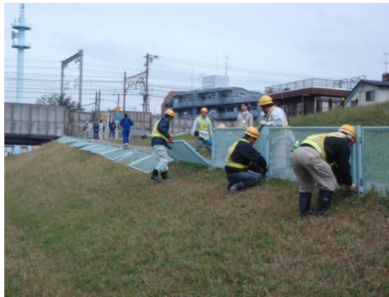
河川敷道路に設置されているフェンスが洪水に備え撤去できるか確認している状況。（管理者が実施した撤去訓練の写真で確認する場合があります。）
