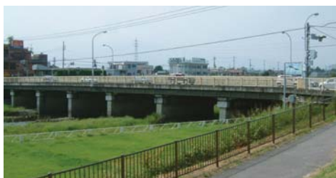
荒川橋 旧橋（大正15年架設）
