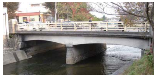
貢川橋 旧橋（昭和6年架設）
