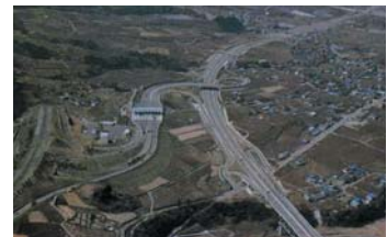
勝沼バイパス 昭和52年に暫定2車線供用、昭和54年に全線4車線供用
