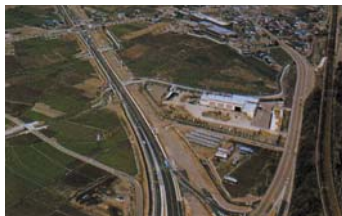
双葉バイパス 昭和51年工事着手、昭和55年4月に暫定供用
