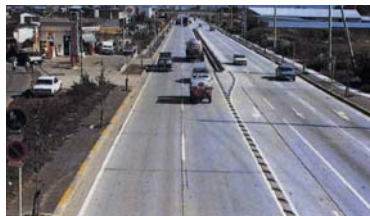
甲府バイパス 昭和46年に暫定2車線供用、昭和49年に全線4車線供用
