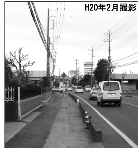
写真2 電柱移設完了
