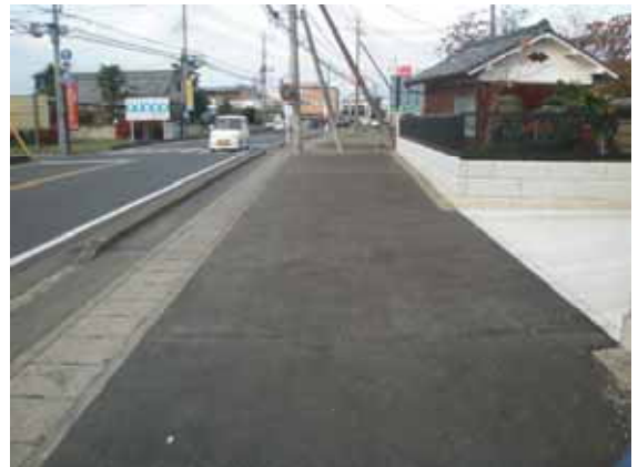
歩道として仮舗装
