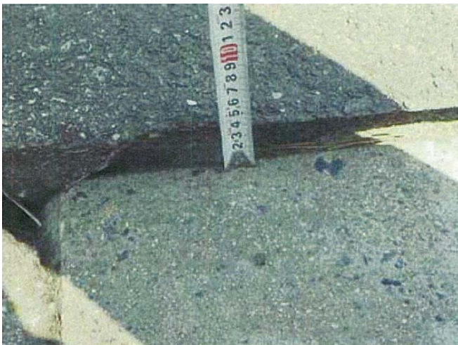
歩道部の段差
