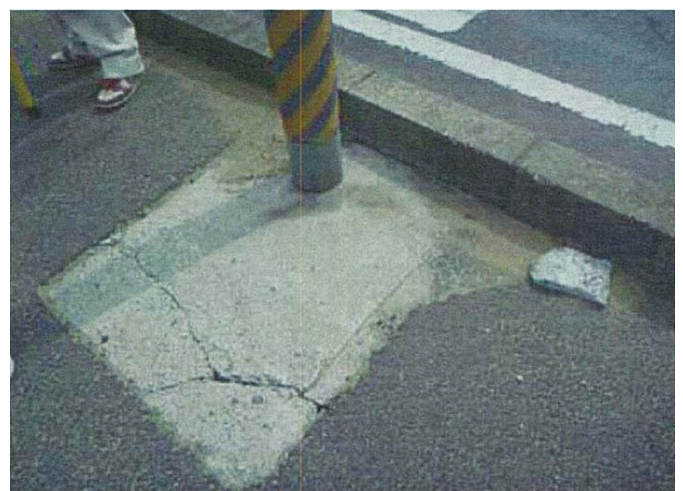
標識基礎部分のひびわれ
