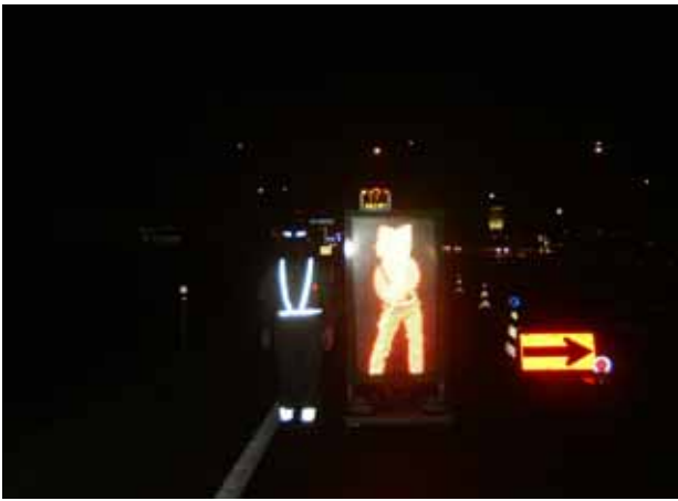
LEDガードマンの設置 (誘導員との夜間時の視認性比較)
