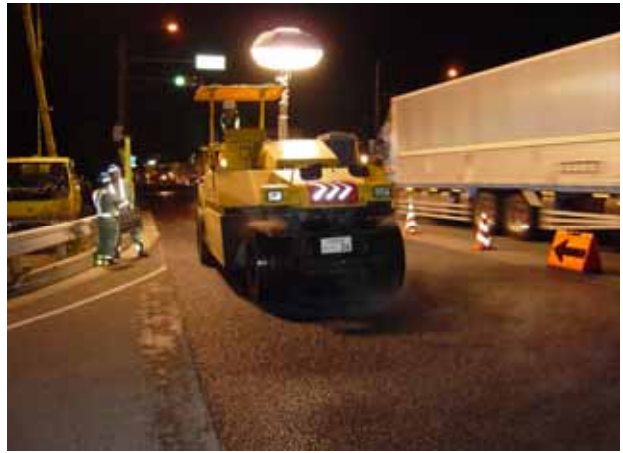
作業機械にバルーンライトを設置
