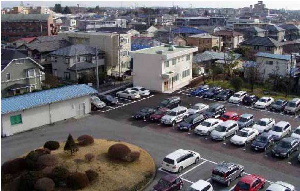
事務所資料倉庫完成
