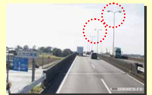
道路管理コスト節約に配慮した 道路照明の消灯実験 (宇都宮国道)
