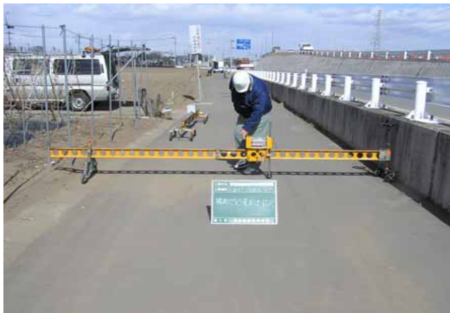
横断プロフィールメータによる測定状況
