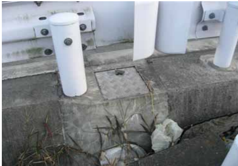
擁壁部に使用(小山市中久喜) 集水方法
