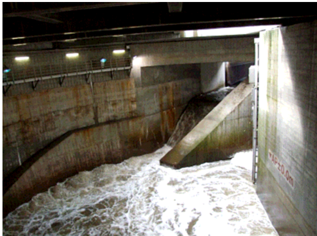
第3立坑(倉松川) 流入状況
