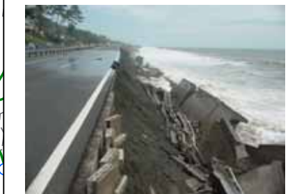
擁壁破損 路面崩壊
