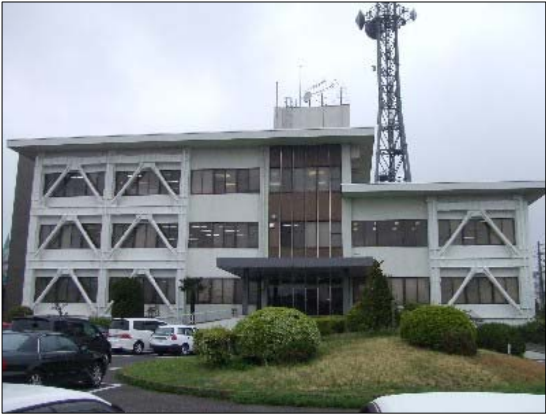
宇都宮国道事務所 庁舎耐震改修：鉄骨ブレース設置
