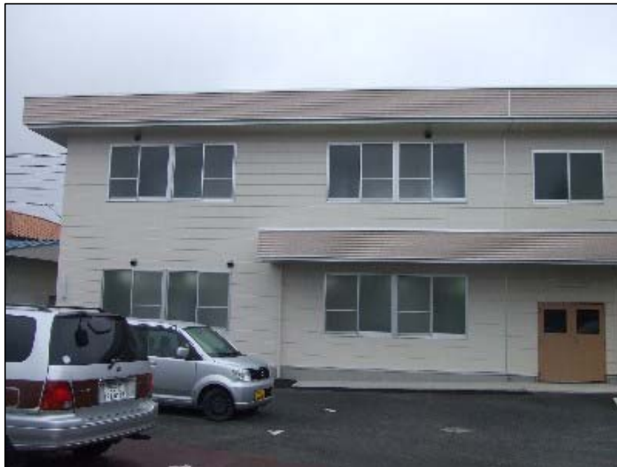
事務所資料倉庫増築棟 西面外観
