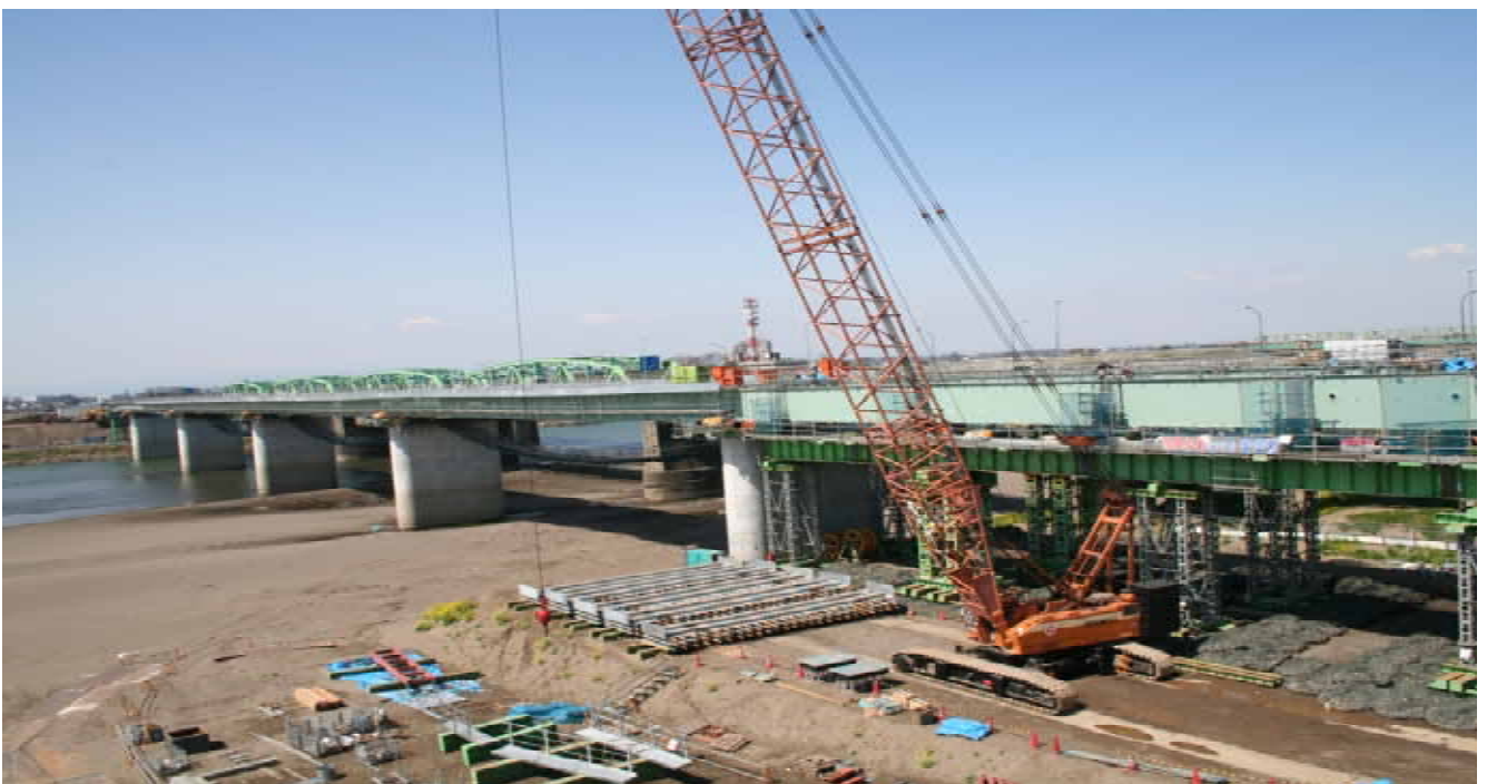
利根川橋（茨城県側より埼玉県側を望む）
