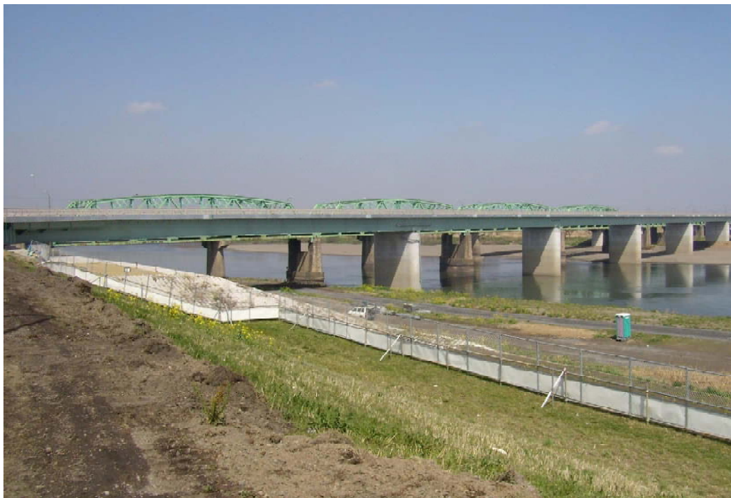
利根川橋全景
