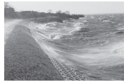
離岸堤と水位管理が無かった場合
