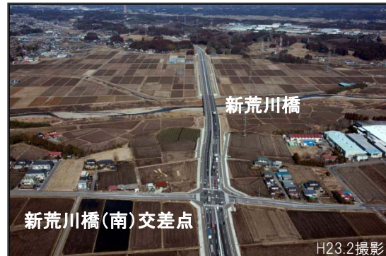
新荒川橋付近(福島方面を望む)
