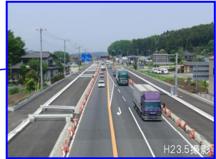
矢板市片岡付近(福島方面を望む)
