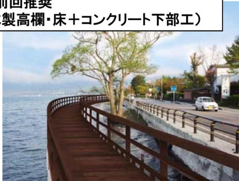
■鋼製高欄+木製床+コンクリート下部工
