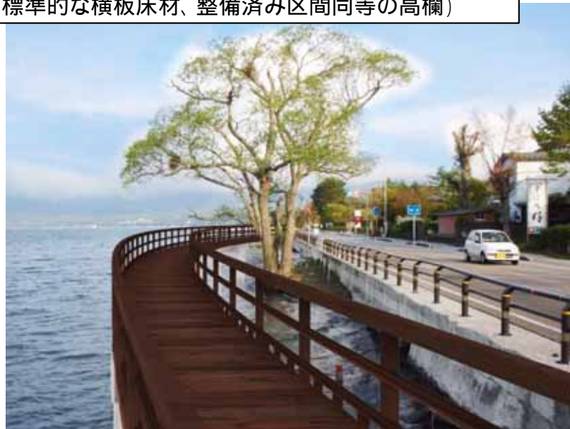
木製栈橋 (標準的な横板床材、整備済み区間同等の高欄)
