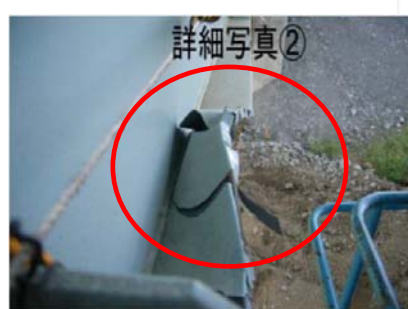
桁損傷状況
