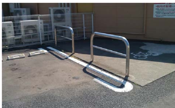
事故発生現場状況(鋼製車止め)
