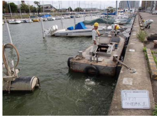
作業船によるアオコ攪拌作業③
