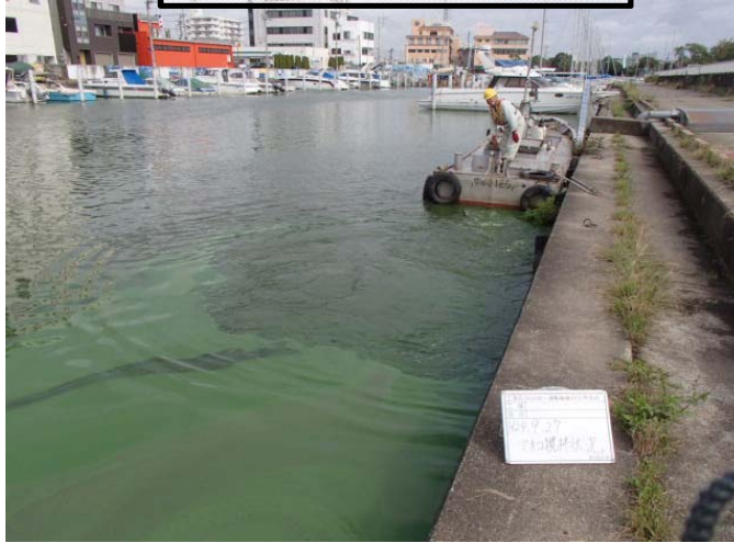
作業船によるアオコ攪拌作業②
