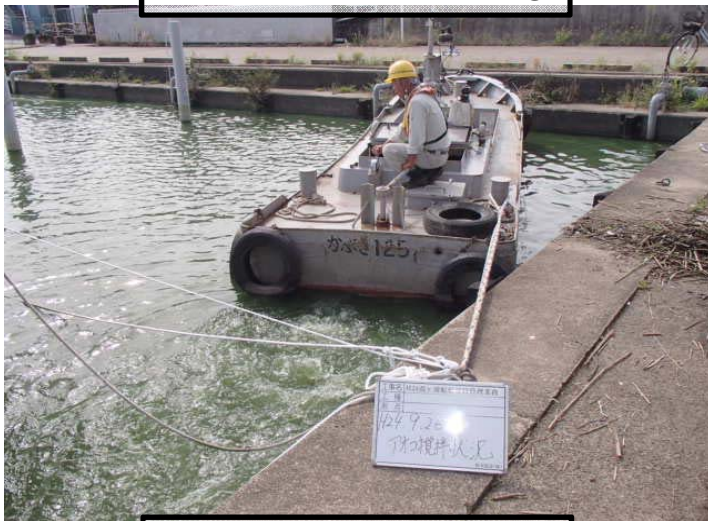
作業船によるアオコ攪拌作業②
