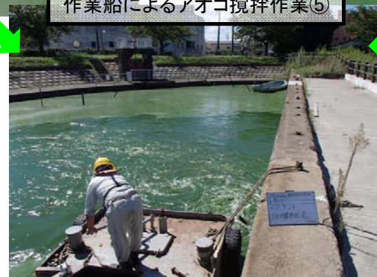
作業船によるアオコ攪拌作業⑤
