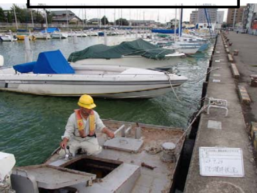
作業船によるアオコ攪拌作業③
