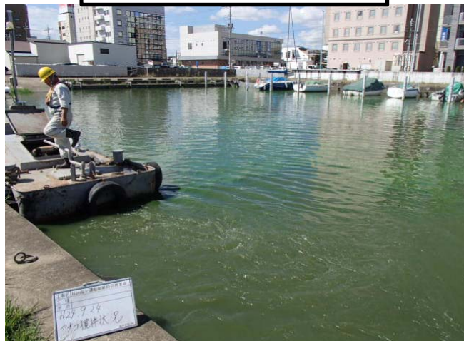
作業船によるアオコ攪拌作業②
