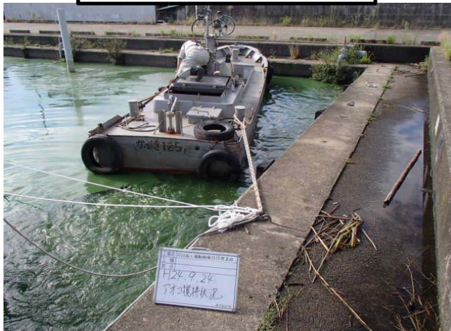
作業船によるアオコ攪拌作業①
