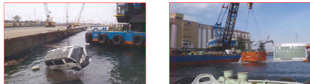
写真 1-18 鹿島港 中央航路及び南航路における沈没物（コンテナ・自動車）の引揚げ
