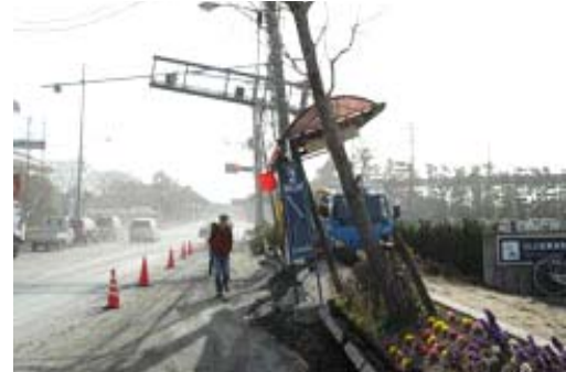
写真 1－5 液状化によって傾いたバス停
