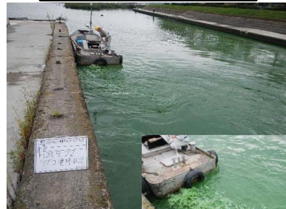
作業船によるアオコ攪拌作業④
