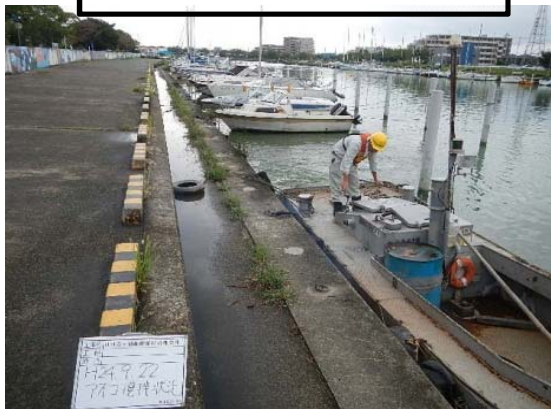
作業船によるアオコ攪拌作業③
