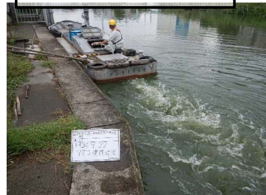
作業船によるアオコ攪拌作業⑤
