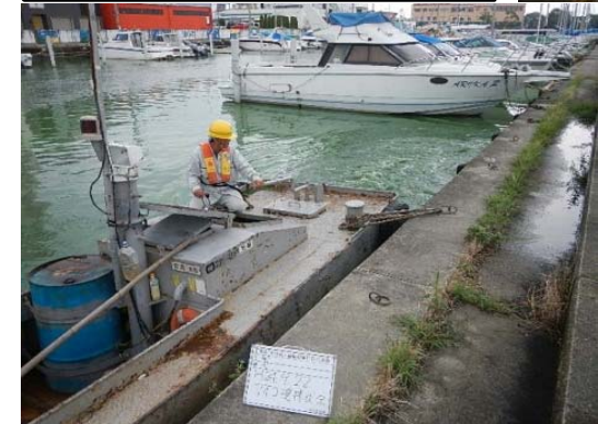
作業船によるアオコ攪拌作業②
