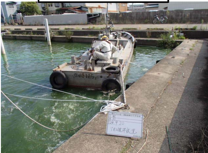
作業船によるアオコ攪拌作業②
