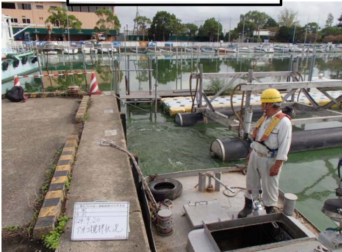
作業船によるアオコ攪拌作業②
