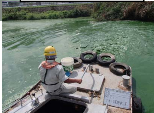
作業船によるアオコ攪拌作業⑤
