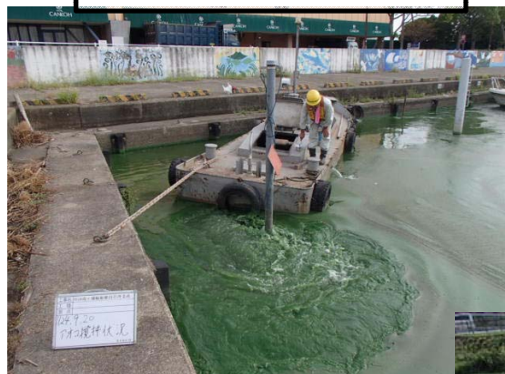
作業船によるアオコ攪拌作業③
