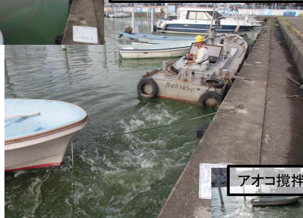
作業船によるアオコ攪拌作業⑤
