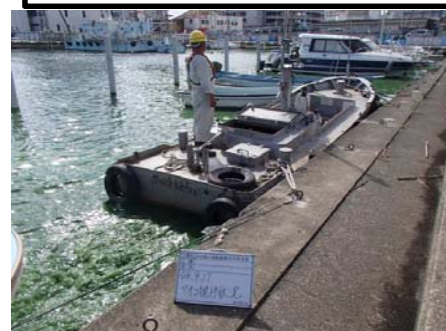
作業船によるアオコ攪拌作業④
