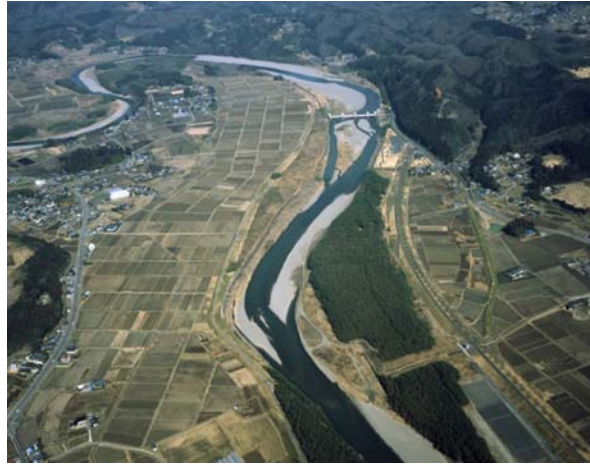
写真 1.3.10 高水敷に樹木が存在する久慈川 30.0k 付近
