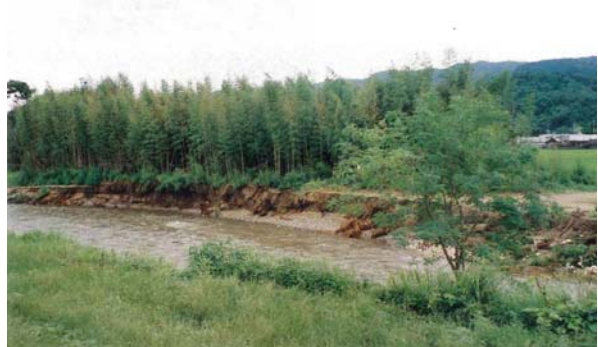
洪水により河岸が侵食（里川6.0k付近） （常陸太田市田渡町）
