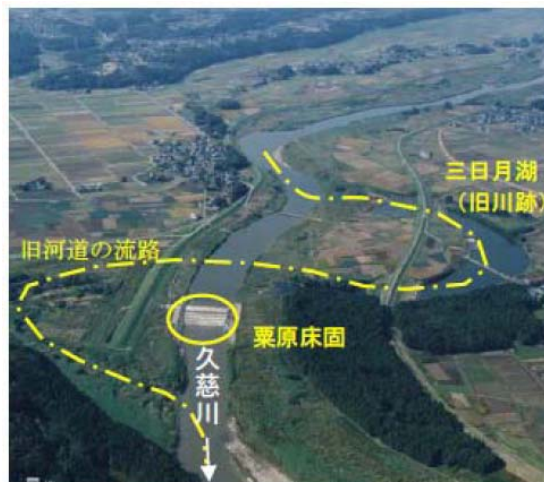
写真 1.3.5 栗原・門部捷水路付近 (14.0k 付近)
