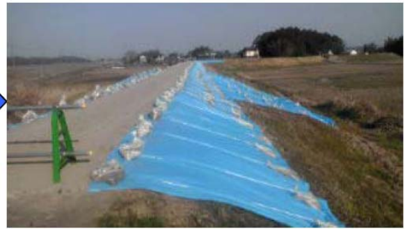
写真 1.3.9 震災による被害の緊急対策（久慈川 右岸 7.0K 付近）
