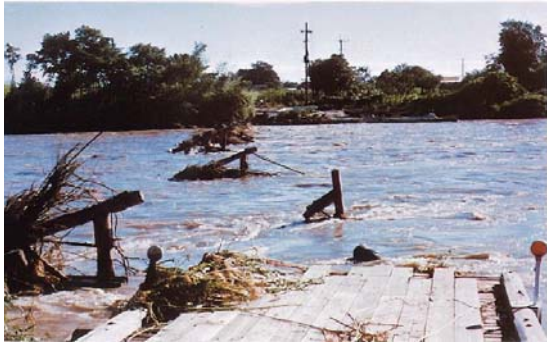
留橋の流出（現日立市留）
