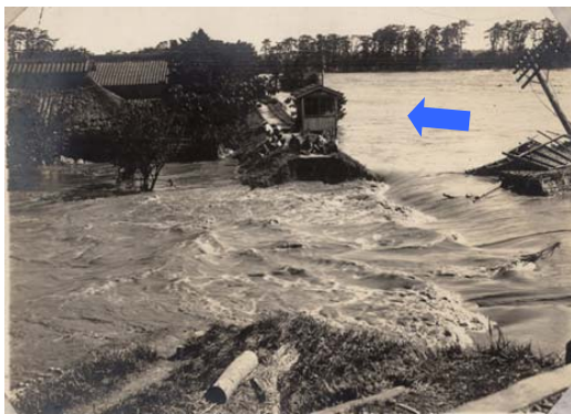
久慈川本川堤防決壊 (左岸) (現日立市留)
