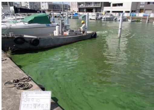
作業船によるアオコ攪拌作業②
