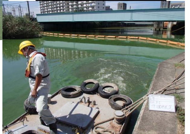
作業船によるアオコ攪拌作業⑤
