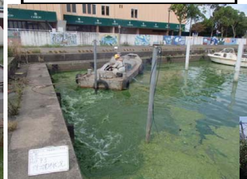
作業船によるアオコ攪拌作業③
